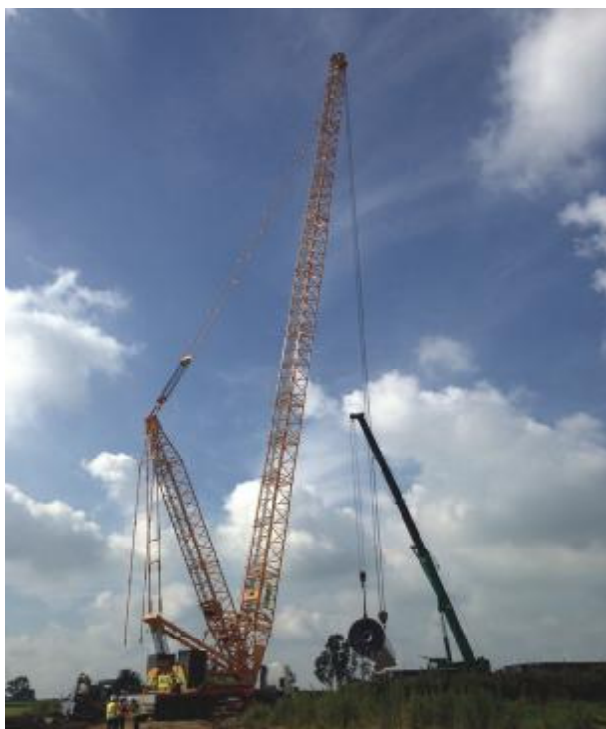
徐工 QUY650 履带吊助力乌拉圭风电项目
