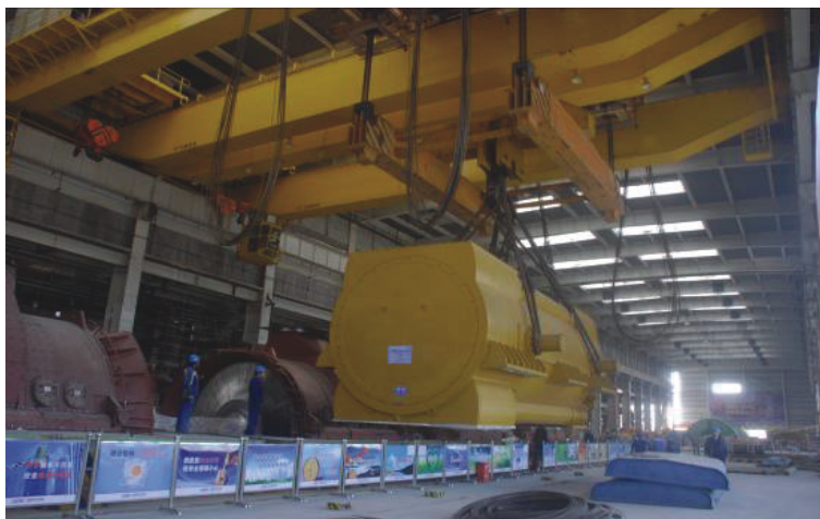
定子绕低压缸吊装
