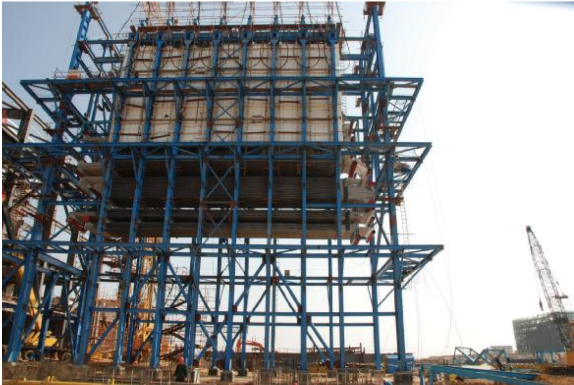
F3—吊装实例照片
