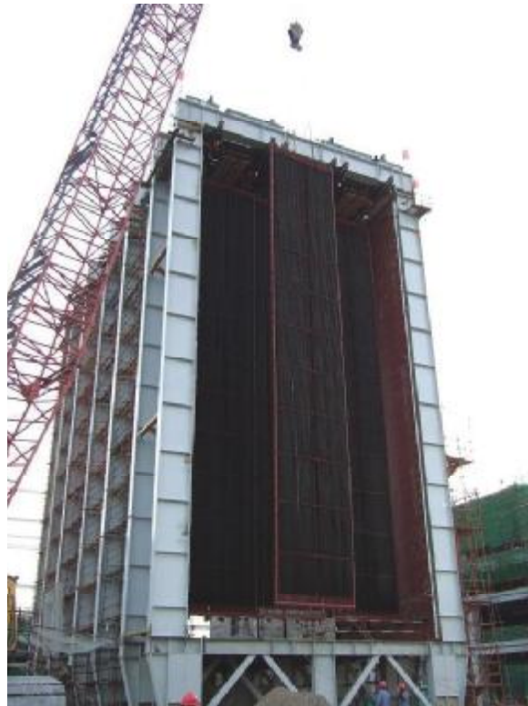
模块吊装进入锅炉内部
