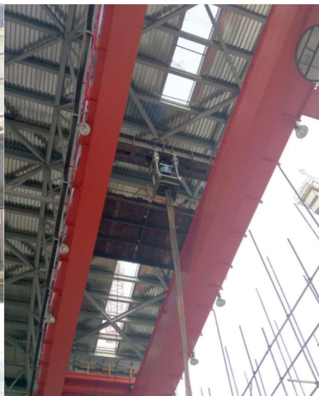
图7 液压千斤顶悬挂装置安装
