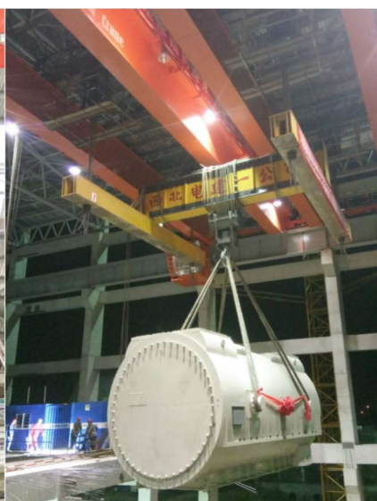
图9 发电机定子吊装实例
