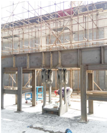
图6 液压千斤顶悬挂装置制作
