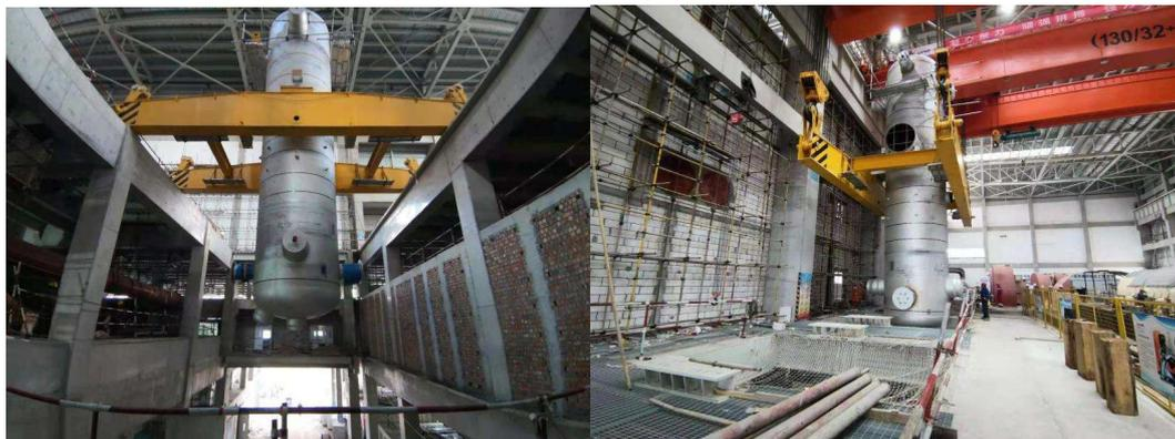
图3 井字架组装及吊装
