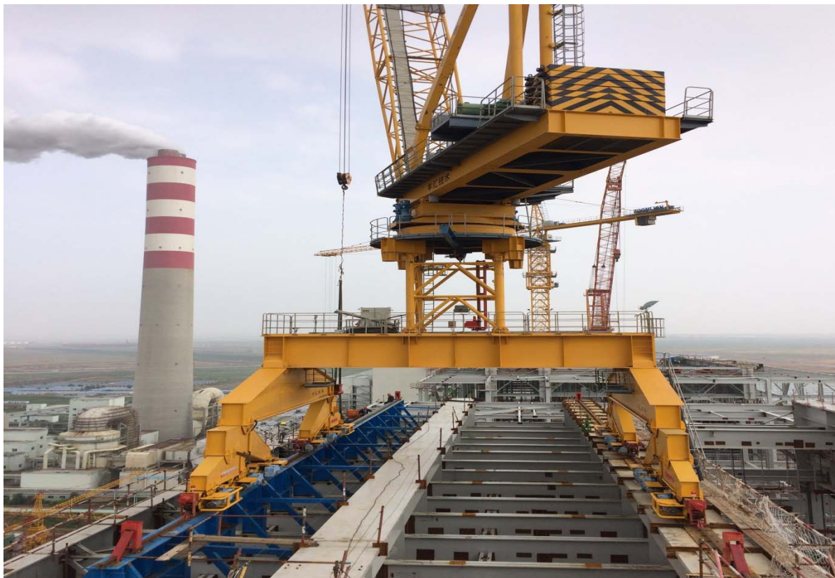
图 5 移动动臂塔式起重机安装完成示意图
