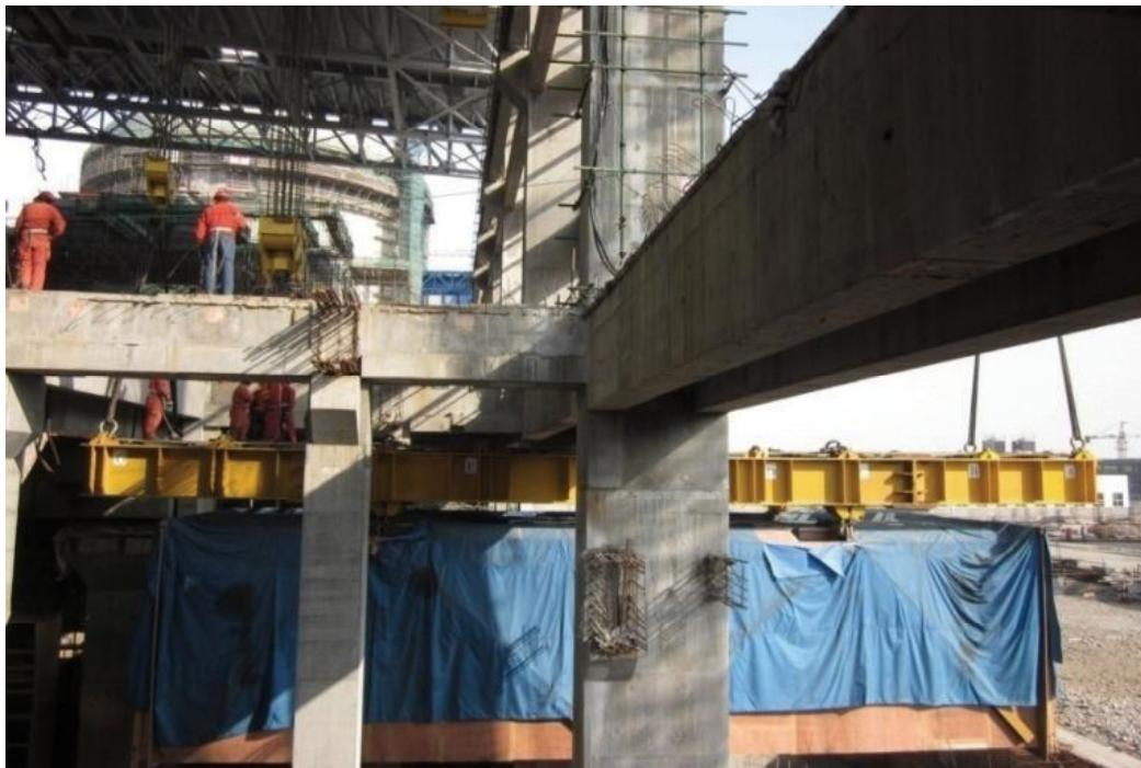
图 4 壳体模块由 250t 行车和外部 1000t 履带吊承载
