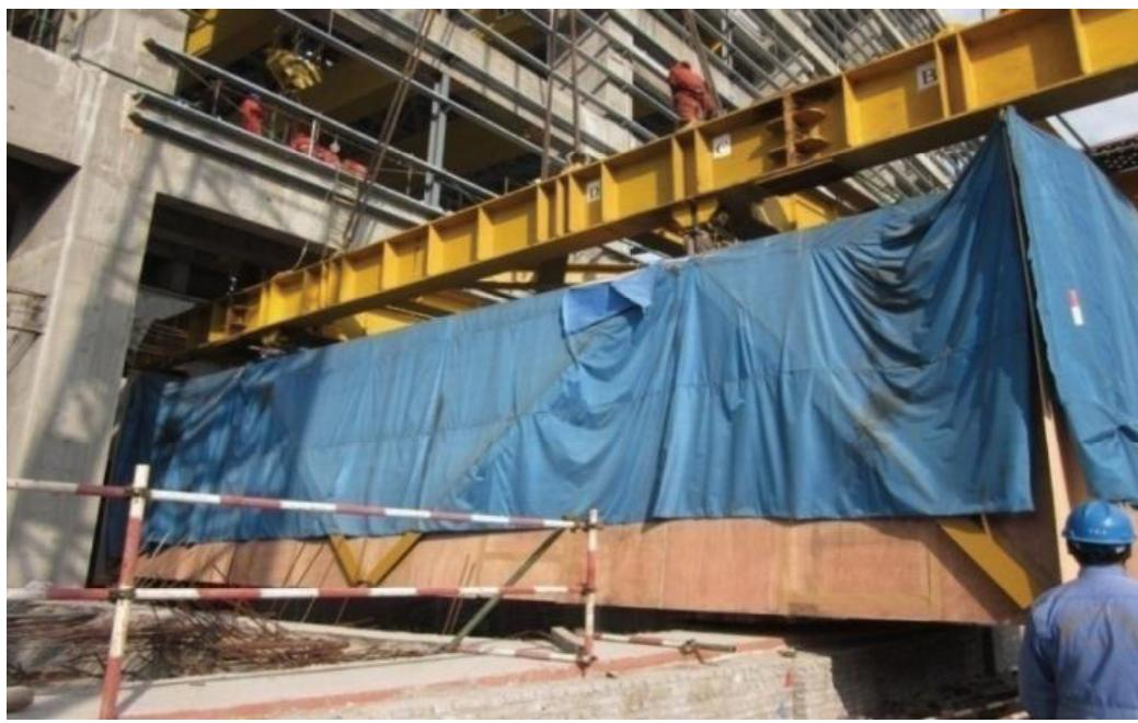
图 2 壳体模块在 400t 履带起重机作用下穿入示意图
