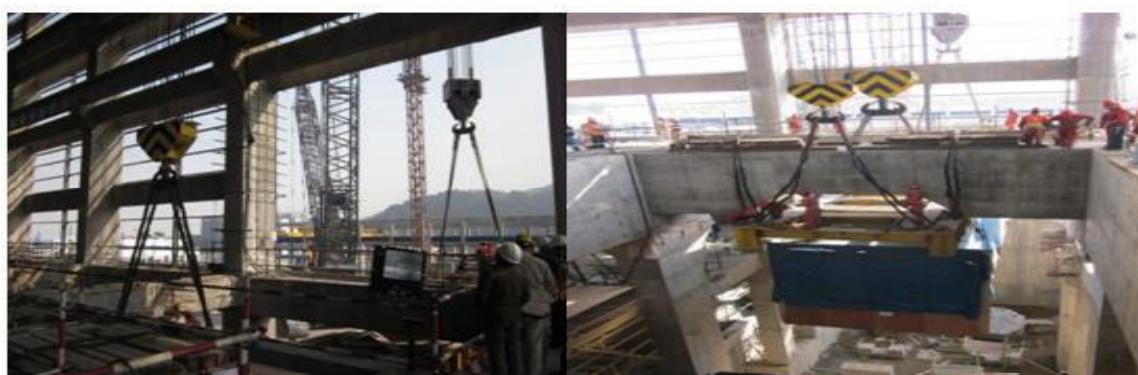
图 5 壳体模块由 80t 行车和外部 1000t 履带起重机承载
