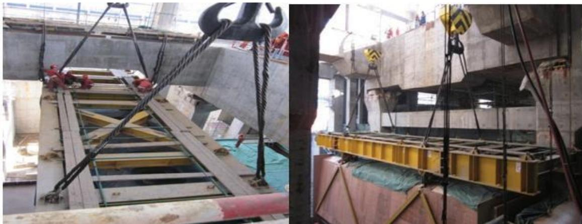
图 9 壳体模块由 250t 行车和 80t 行车承载就位
