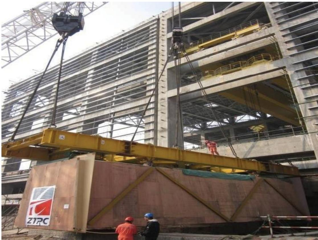
图 3 壳体模块在 80t 行车和外部 1000t 履带起重机下换钩
