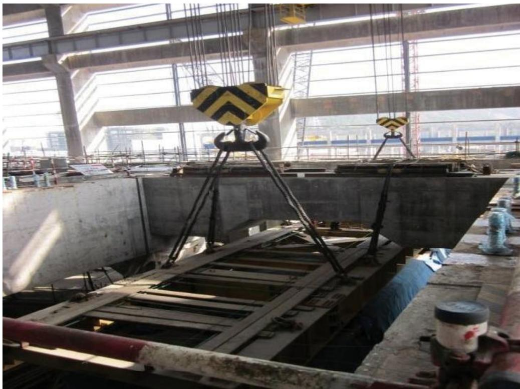
图 8 壳体模块由 250t 行车和低压缸基础大梁承载
