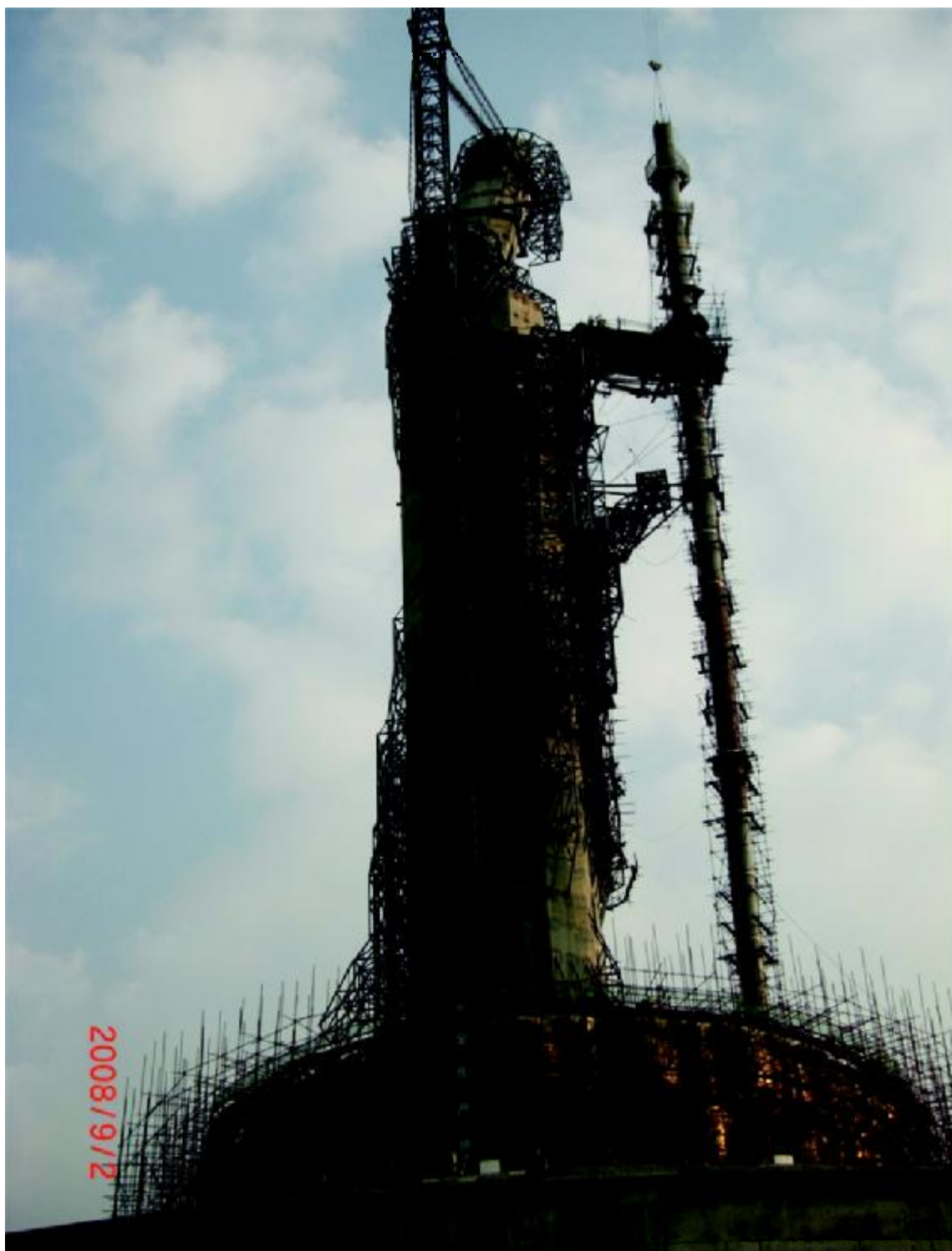
附图二：锡杖管件吊装过程图
