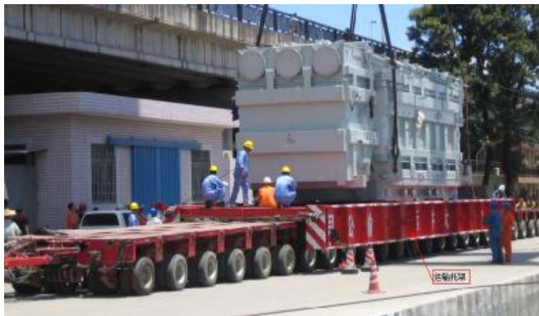
图1 某变电站主变压器使用托架运输
