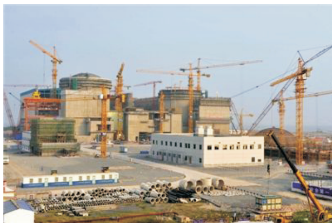
正在加紧建设的广西防城港核电站
