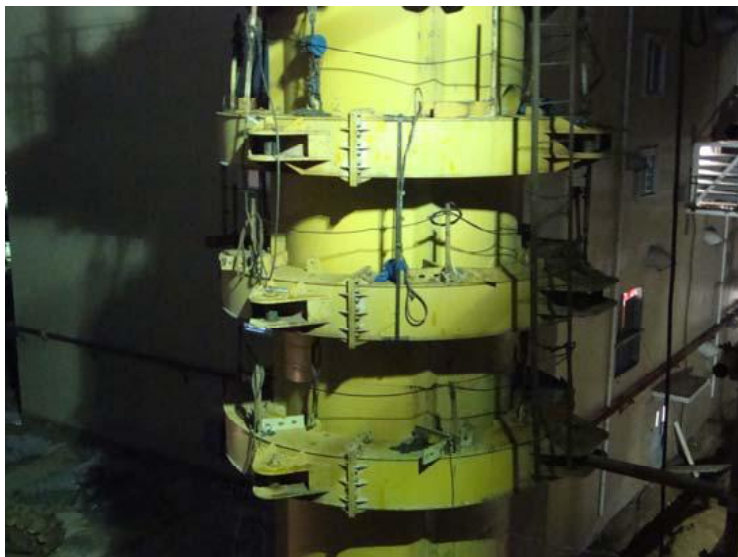
图一：抱攀改进前连接方式图
