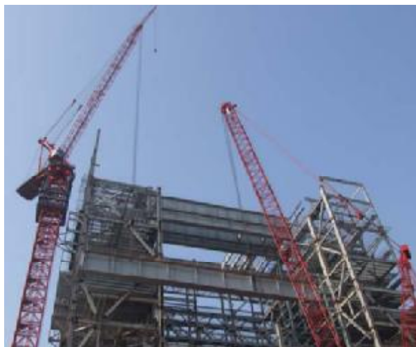
图 4-1 K4 板梁吊装
