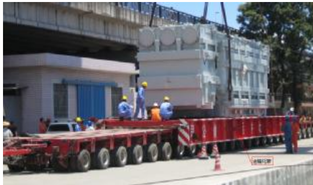
图1 某变电站主变压器使用托架运输
